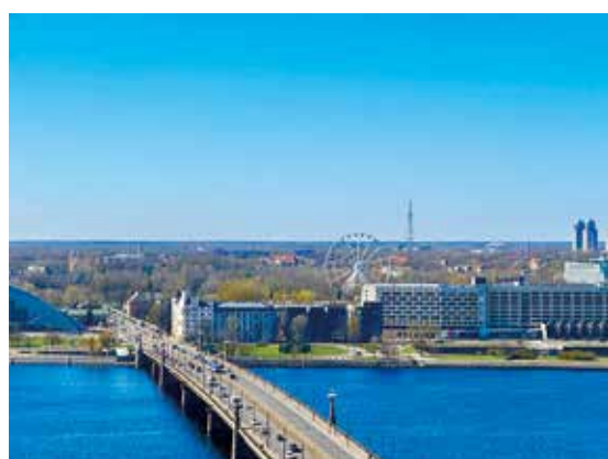
里加石橋是橫跨道加瓦河的重要橋樑。連接里加舊城區與道加瓦河左岸。
